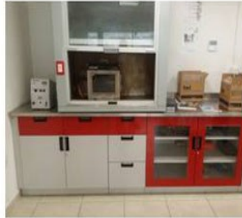
CABINA DE EXTRACCIÓN DE HUMO
